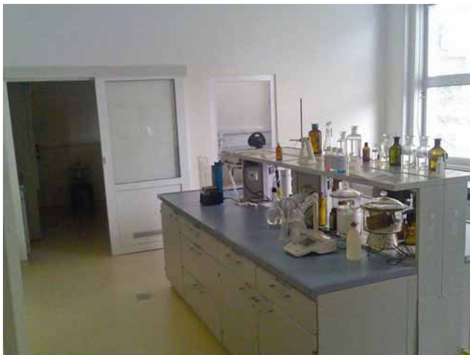
Uređen laboratorij oštećen u požaru 2007. godine
