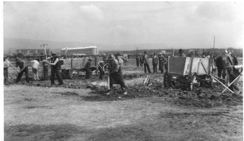
Početak izgradnje glavne zgrade Fakulteta. Fotografija je snimljena 24. svibnja 1938. godine (arhiva Fakulteta).
