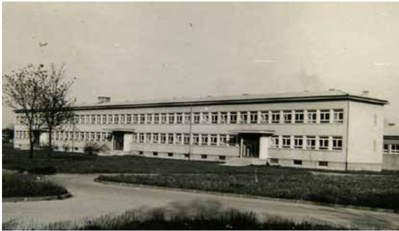
Završna faza izgradnje kliničke zgrade Fakulteta s uređenjem prilaznog puta 1959. godine (arhiva Fakulteta).
