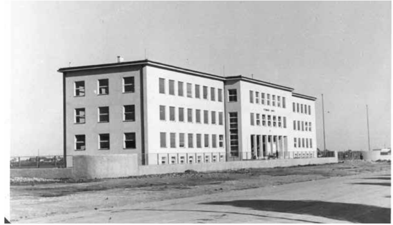
Dovršena glavna zgrada Fakulteta s izgrađenom ogradom prema Heinzeloj ulici i dijelu Planinske ulice. Fotografija je snimljena u rujnu 1940. godine (arhiva Fakulteta).
