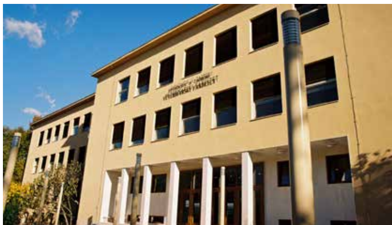
Pročelje glavne zgrade Fakulteta. Posljednja adaptacija pročelja bila je 2004. godine.
