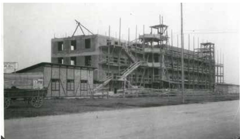
Izvedba konstrukcije glavne zgrade Fakulteta u završnoj fazi. Fotografija je snimljena 12. kolovoza 1938. godine (arhiva Fakulteta).
