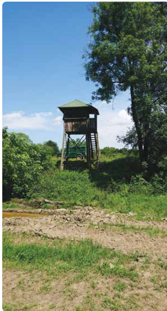
Slika 4. Obnovljena visoka čeka broj 19
