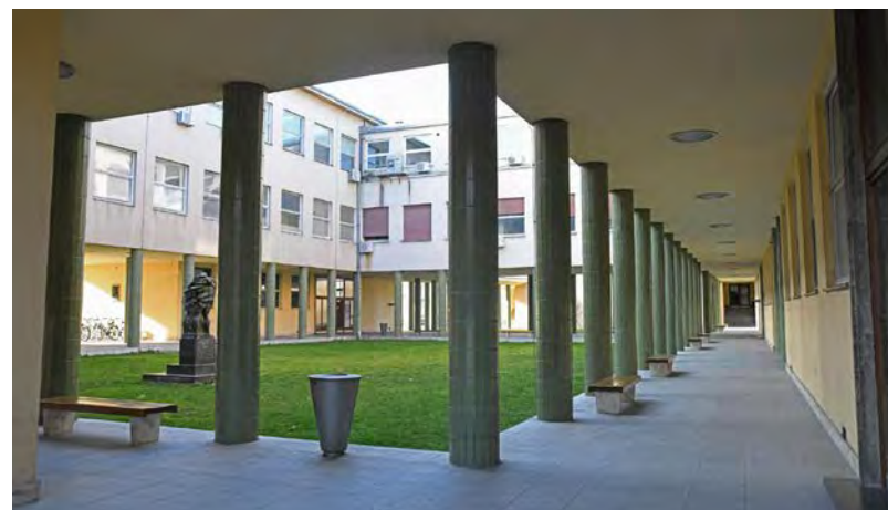
Natkriveni prolaz s okruglim popločanim stupovima je između glavne zgrade i kompleksa zgrada zavoda jedno je od karakterističnih obilježja Fakulteta.
