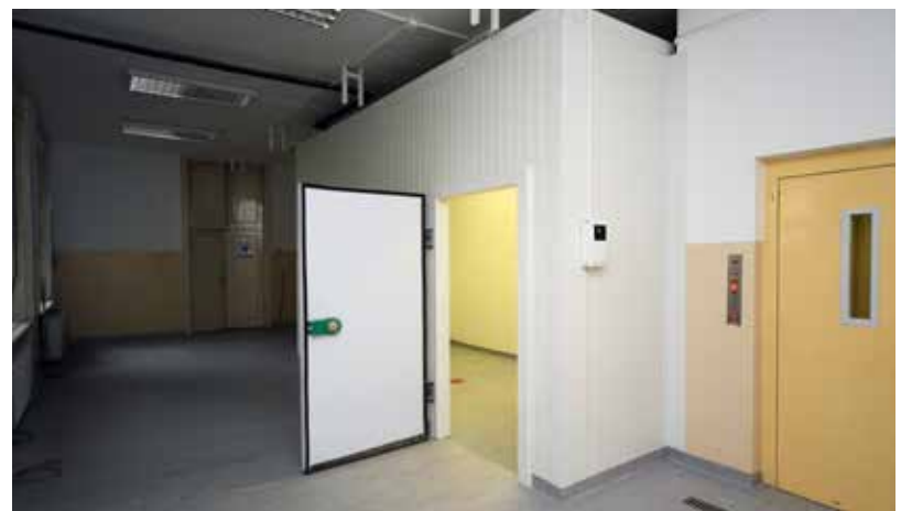
Prostor za pripremu anatomske preparata u prizemlju Zavoda poslije obnove. Na mjesto srušenih spremnika postavljena je hladna komora.
