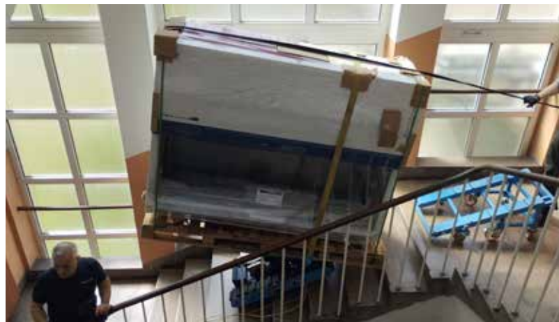
Detalj kompliciranog transporta opreme (mikrobiološki zaštitni kabinet) na drugi kat zgrade.
